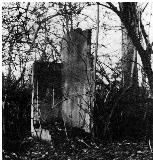
Reste der zerstörten Synagoge
