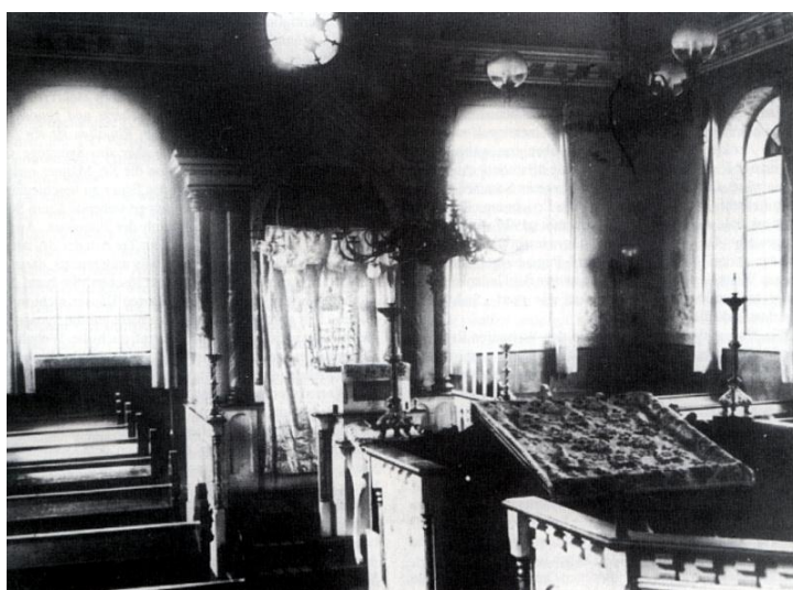
Vor der Zerstörung in der Synagoge
